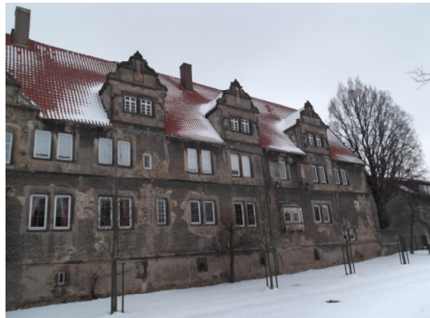
Teilansicht der Fassade des „Münchhausenschlosses“; Ansicht von der Seite der hier abgetragenen Wallanlagen
