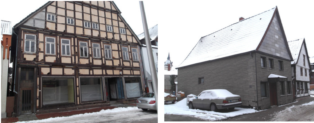
Links: Unverkleidete, aber schadhafte Giebelfassade mit leer stehendem Laden; rechts: kunststoffverkleidete Fassade
